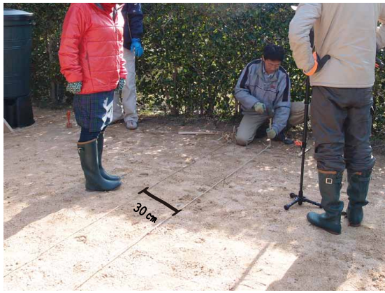
↑ロープ張りの作業風景
